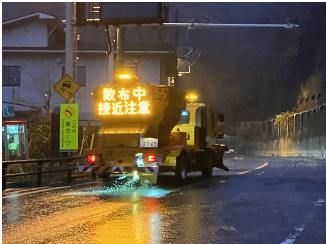
凍結防止剤散布状況 (令和6年11月7日 国道17号三国峠)
