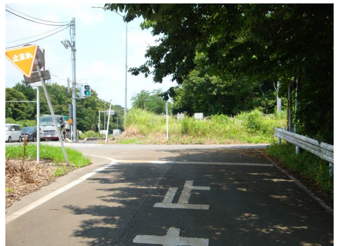
⑤ 撮影方向：北方向、国道東側側道
