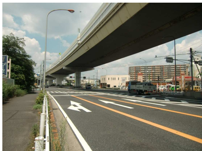
④ 撮影方向:北 片側3車線 中央分離あり、右折専用レーンあり
