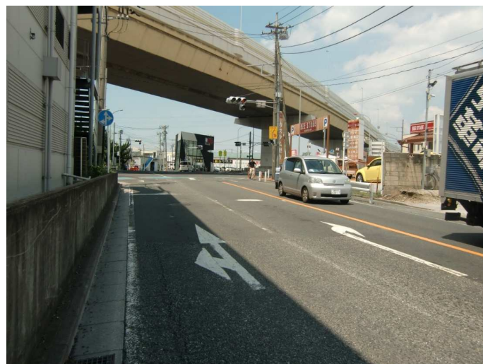
③ 撮影方向:北西 片側1車線 右折レーンあり、交差点中央に首都高速の高架あり
