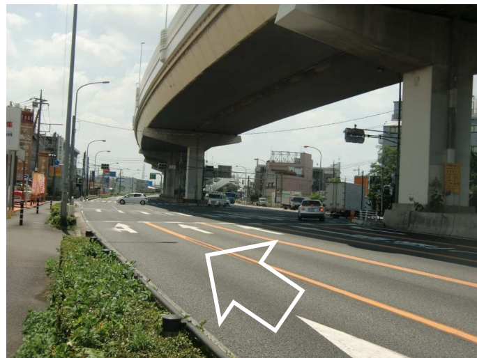
① 撮影方向:南 右折レーン高速入口直進レーンあり、中央分離に首都高速の高架あり
