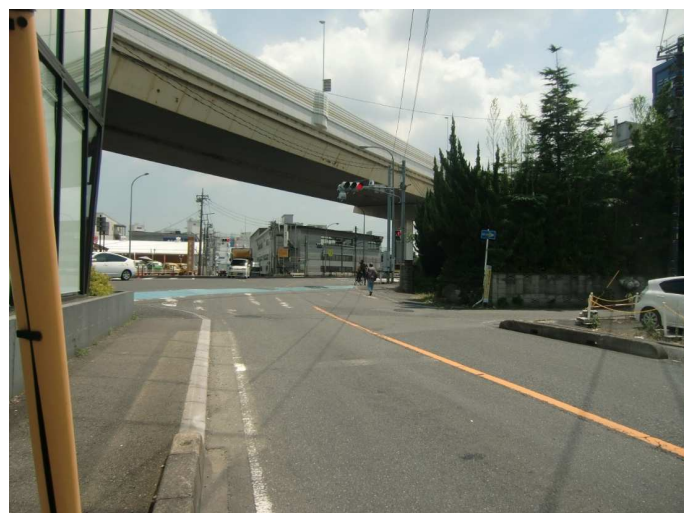
⑤ 撮影方向:南東 片側1車線 交差点中央に首都高速の高架あり
