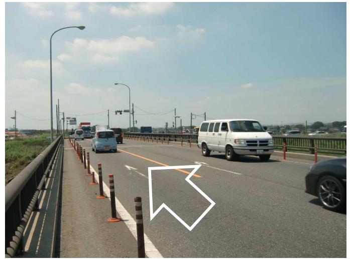
① 撮影方向：南西 片側1車線 野田橋橋上
