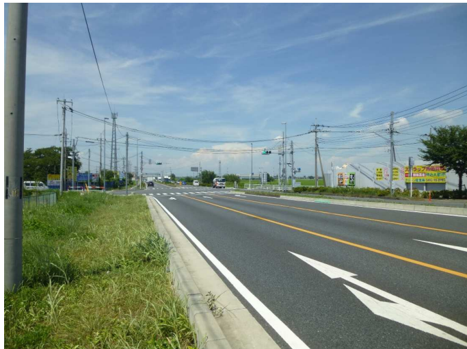
④ 撮影方向：北 片側2車線 中央分離帯あり 右折レーンあり
