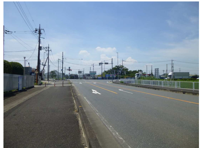
③ 撮影方向：西 片側1車線 右折レーンあり
