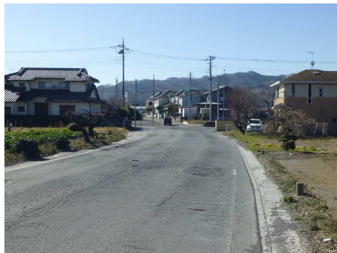
③ 撮影方向:南西 片側1車線 南西側に交差点あり
