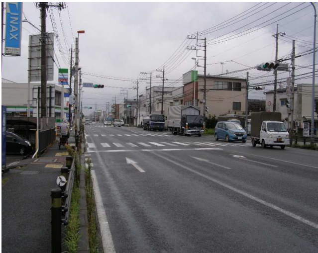
② 撮影方向:北東 片側2車線 右折レーンあり
