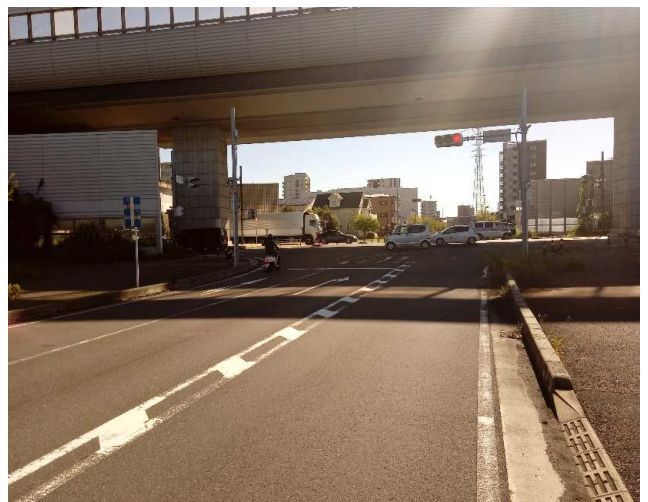
⑤ 撮影方向:東 片側1車線 右折レーンあり
