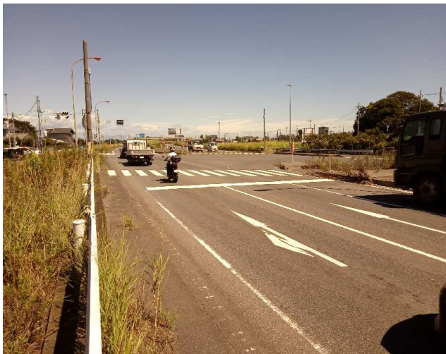
② 撮影方向:北西 片側2車線 右折レーンあり
